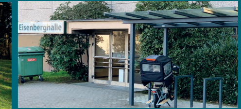
Sanierung der Eisenberghalle (Heizung, Lüftung)
