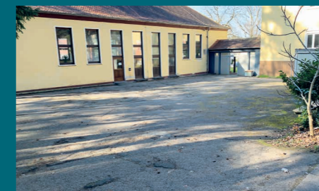
Sanierung des Schulhofes der alten Schule und der Eisenbergschule
