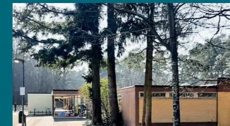
Mehr Sicherheit für die Grundschüler der Eisenbergschule durch geeignete Maßnahmen
