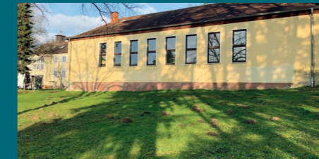
Sanierung der alten Schulturnhalle
