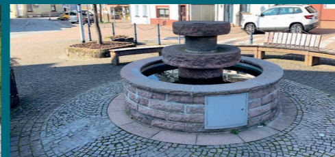
Sanierung des Brunnens auf dem Marktplatz
