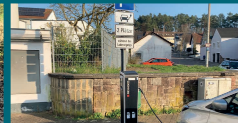
Errichtung einer E-Ladesäule (Marktplatz)
