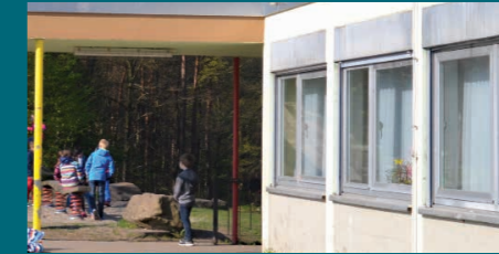
Energetische Sanierung des Lehrertraktes der Eisenbergschule
