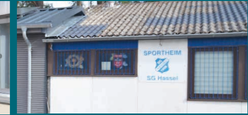
Sanierung des Daches des Sportheims
